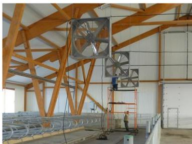
**Разгонные вентиляторы**, устанавливаемые по всему помещению, создают подвижность воздуха и обеспечивают его перемешивание. Обдув животных свежим воздухом способствует снижению теплового стресса и увеличению поедаемости кормов. Простота монтажа позволяет устанавливать вентиляторы, не беспокоя при этом животных, содержащихся в здании. Универсальное решение для ферм с привязным и беспривязным содержанием животных.
